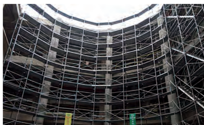
ショッピングモールの内部吹抜け 円形用足場はRの内側にも設置可能
