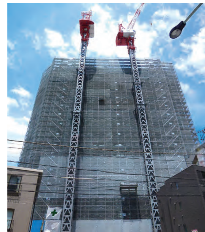
高さ80メートル超のタワーマンション 強化方づえ使用 B2階からの立ち上りの 足場部分は最高高さ約90メートル
