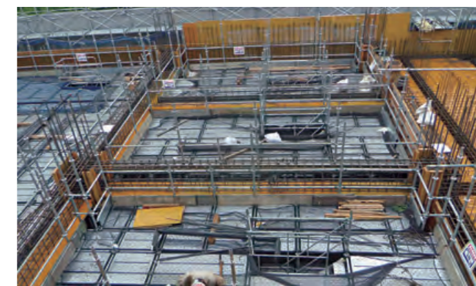
支保工のステージ 作業床は段差なく手すり付き昇降設備も容易 在来型枠支保工と組合せて設置し、存置期間後は設備工事用のステージとしても 無駄なく利用可能
